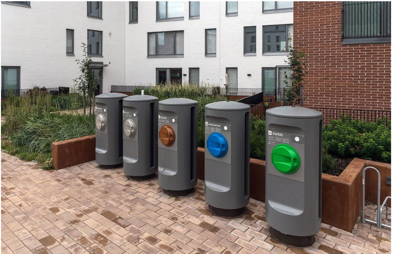
Фото: наружная часть вакуумного мусоропровода в многоквартирном доме в Финляндии.
