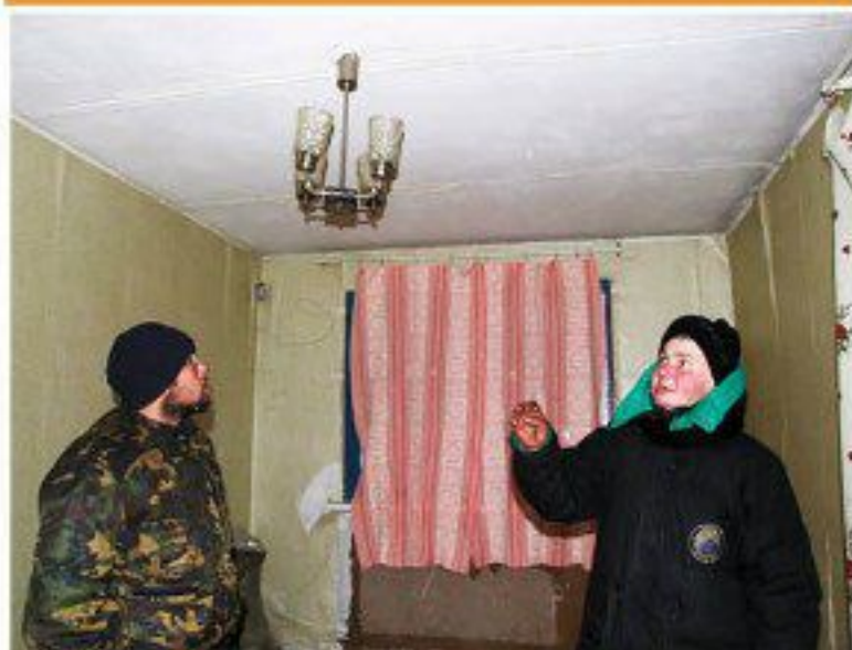
Сергей и Олеся осматривают временное жилье и оценивают объем ремонтных работ.
